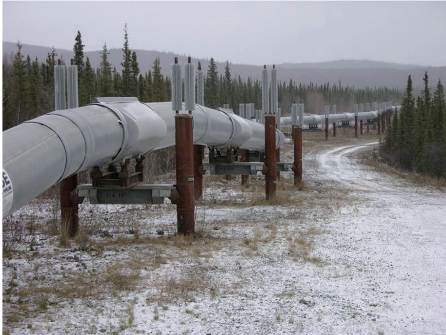
〈그림 7〉 알래스카 툰드라를 가로지르는 석유 파이프라인 (출처: commons.wikimedia.com).
